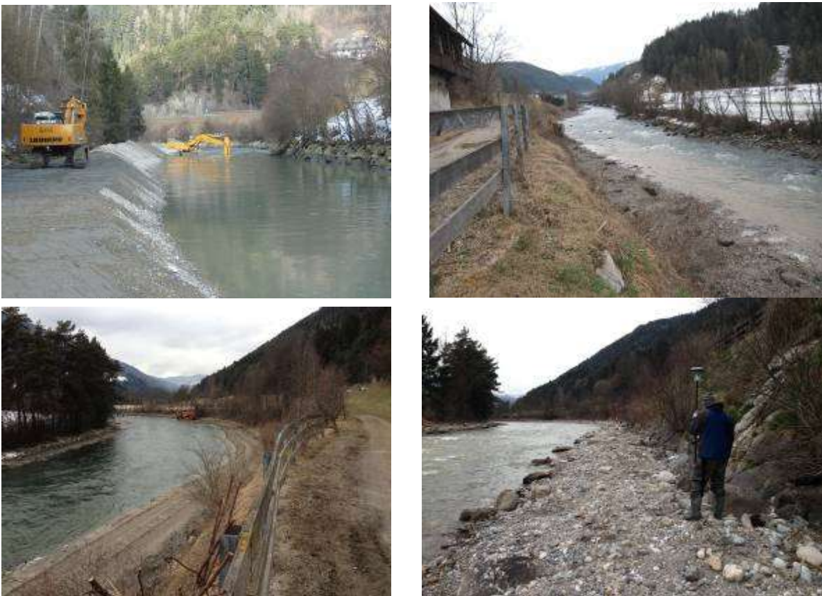
Figura 43 - Reintroduzione di sedimenti a valle di uno sbarramento idroelettrico sul fiume Rienza (Provincia Autonoma di Bolzano – Ripartizione Opere Idrauliche).
