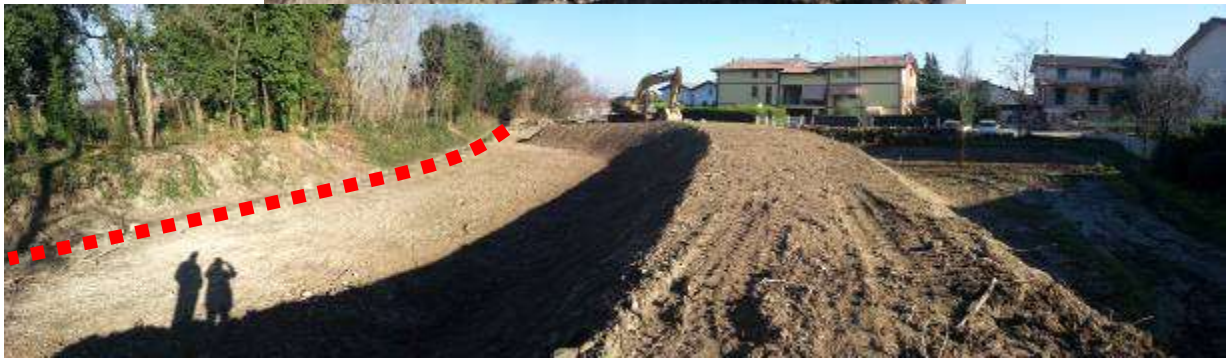
Figura 7 - Esempio di arretramento arginale lungo il rio Enzola (Provincia di Reggio Emilia).
