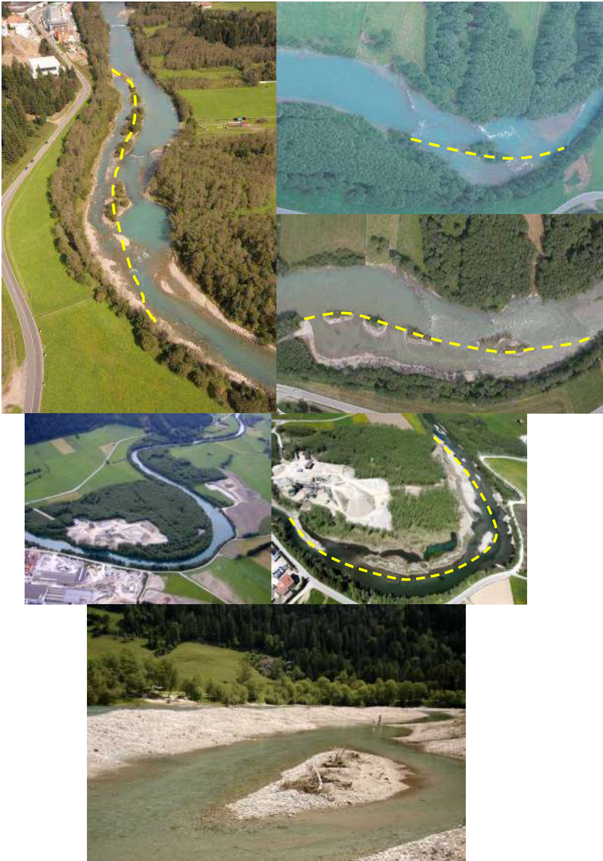
Figura 22 – Esempio di rimozione di difese spondali e allargamento di sezione. Immagini in alto: intervento realizzato lungo il torrente Aurino a Campo Tures (Provincia Autonoma di Bolzano).
