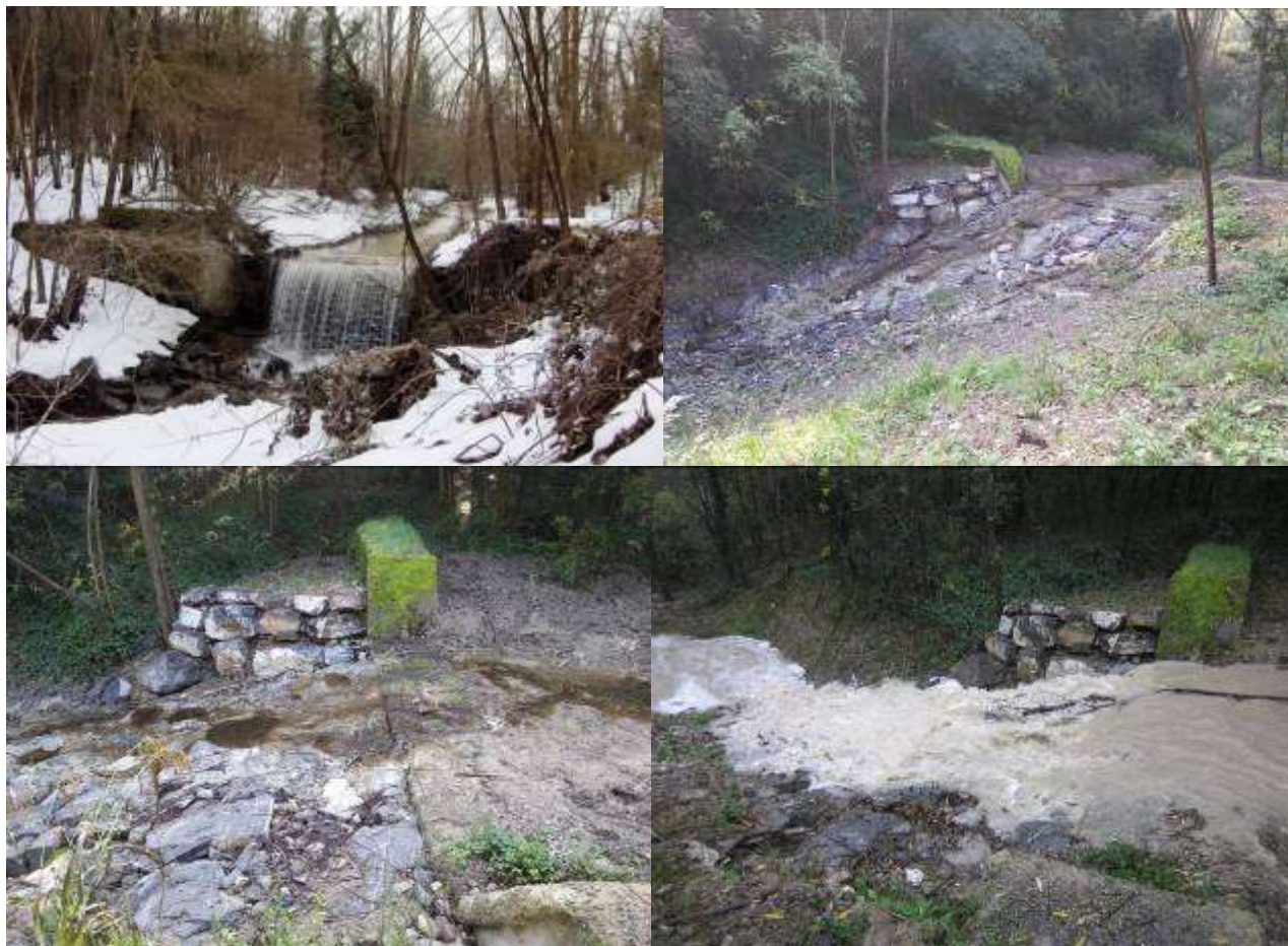
Figura 35 – Esempio di modifica di una briglia lungo il rio Lavezza nel Comune di Albinea (RE)
