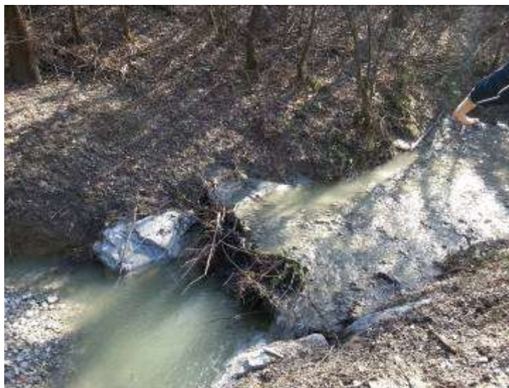
Figura 38 - Esempio di costruzione di un piccolo sbarramento in tronchi, massi e radici esposte lungo il rio Bianello in comune di Quattro Castella (RE).
